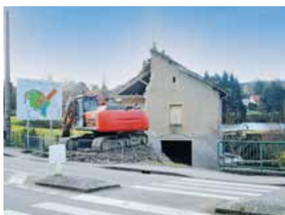
Démolition maison étang 2014
