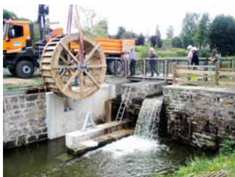
Installation roue à l'étang 2018
