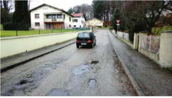
Les nids de poule et déformations justifient une reprise de la chaussée
