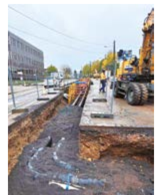
Conduites d'un réseau de chaleur posées sous chaussée
