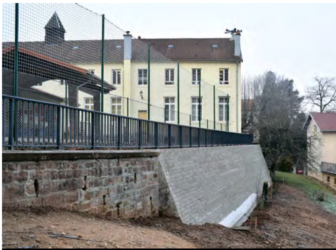
La dépense engagée pour la reconstruction du mur est de 220 000 €
