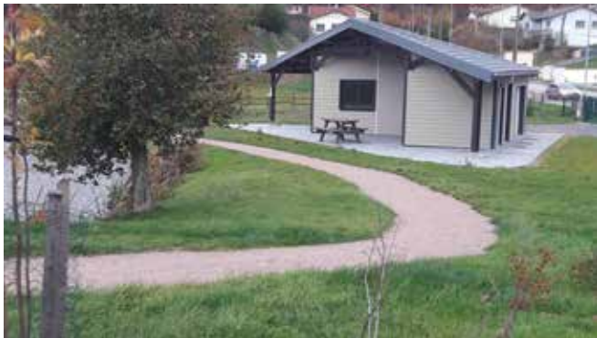
Aménagement abords du chalet à l'étang
