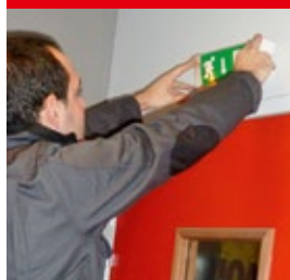
Eclairage de sécurité
