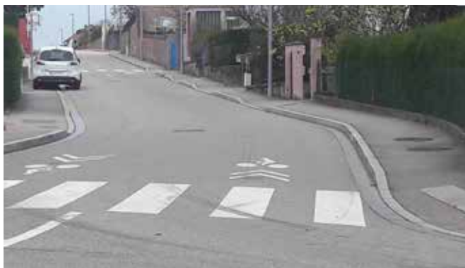
Signalisation horizontale rue Français
